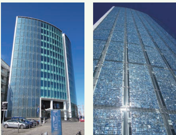
撮影:ALM Brandビル 建材一体型太陽電池(BIPV)パネルにPilkington Eclipse Advantage™ , Optifloat™ , Optiwhite™ を使用
